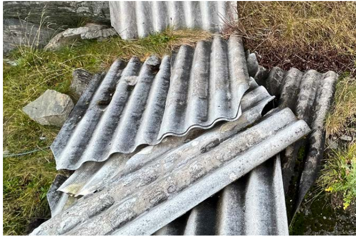
Takplater av eternit.
